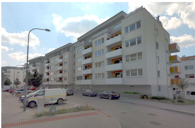
Ilustrační foto objektu, na němž je nebo bude umístěná základnová stanice.
