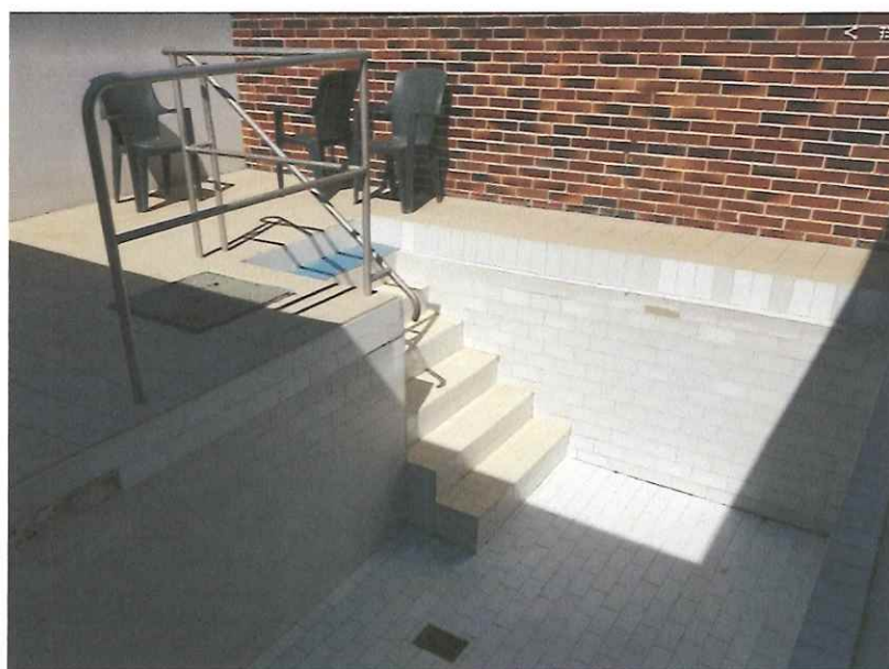
Obr. č. 3 Ochlazovací bazén sauny
